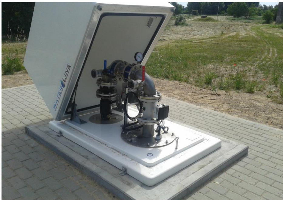
Przykładowa naziemna termoizolacyjna obudowa studni głębinowej
